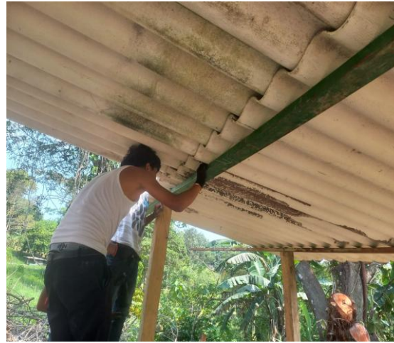
Arreglo del techo
