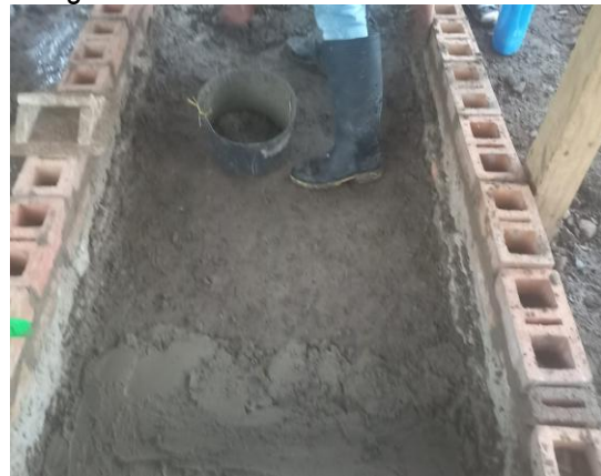
Construccion de camas
